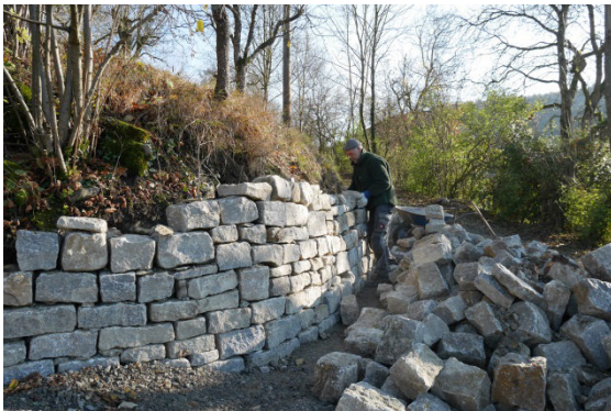
Abbildung 8: In mühevoller Handarbeit werden die Steine der neuen Mauer an der Sonthalde aufeinander gesetzt.
