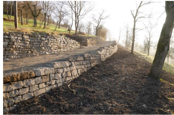
Abbildung 6: Wiedererrichtete Trockenmauern an der Sonthalde in Künzelsau
