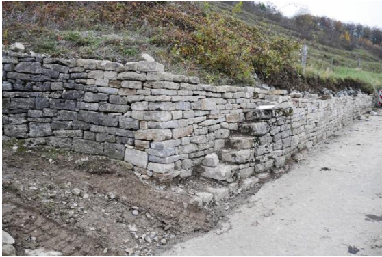
Abbildung 8: Sanierte Trockenmauer; auch die alte Steige ist wieder hergestellt
