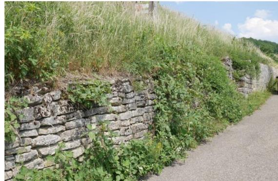
Abbildung 7: Trockenmauer am Hohenberg in Ingelfingen vor der Sanierung.
