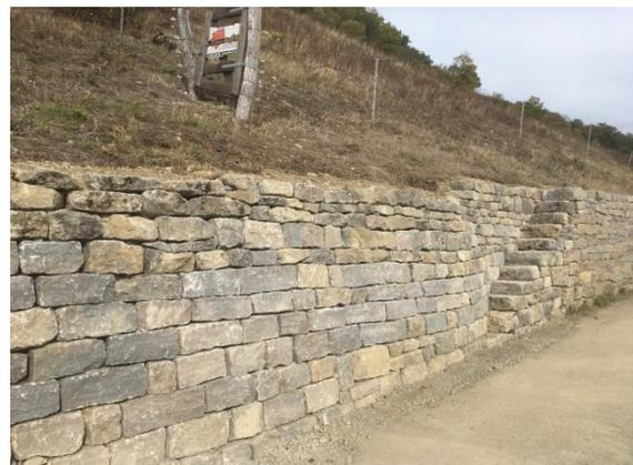
Abbildung 8: Trockenmauer in Ingelfingen nach der Sanierung mit wieder zugänglicher Steige.
