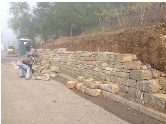
Abbildung 6: Sanierung der Trockenmauer am Flatterberg im Herbst 2018.
