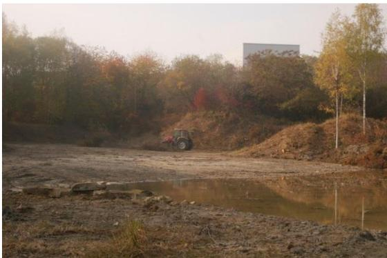
Abbildung 10: Die anaerobe Schlickschicht wurde mit-samt dem Schilfaufwuchs entfernt, auch der dichte Gehölzaufwuchs wurde stark aufgelichtet.
