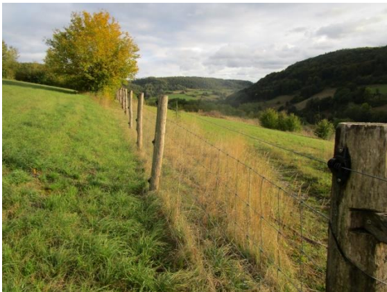
Abbildung 19: Knotengitter-Zaun aus Federstahl
