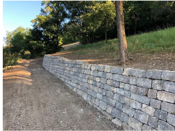
Abbildung 15: Trockenmauer am Ellbach in Forchtenberg nach der Sanierung
