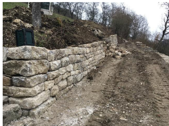
Abbildung 17: Trockenmauersanierung in der Sonthalde in Künzelsau kurz vor Fertigstellung
