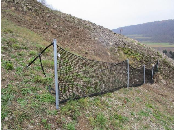
Foto 10: Das Steinschlagschutznetz soll nur während der Beweidung aufgestellt sein, um Anrainer vor herunterrollenden Steinen zu schützen und gleichzeitig keine dauerhaften negativen Auswirkungen auf das Landschaftsbild zu haben.
