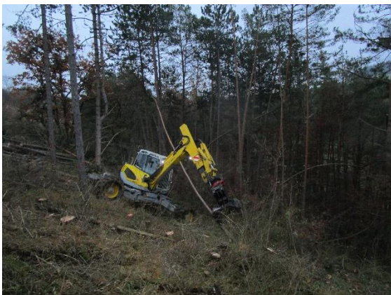
Foto 1: Ausstockung mit dem Schreitbagger.
