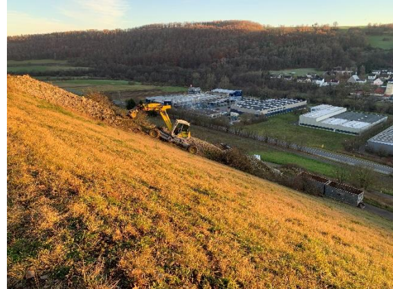
Foto 9: Schreitbagger beim Entbuschen von Steinriegeln im steilen Gelände.
